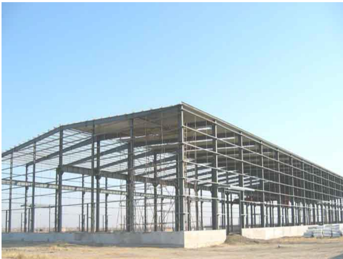
Slika 1 - Primjer čelične rešetkaste konstrukcije [8]
