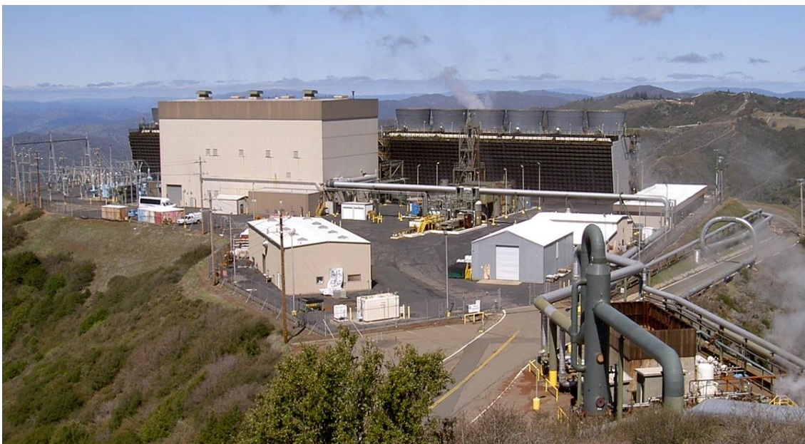
Slika 19. Geotermalne elektrane Geysers [28]
