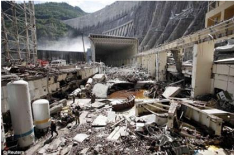
Slika 21. Šest uništenih generatora na hidroelektrani Sayano-Shushenskaya [40]
