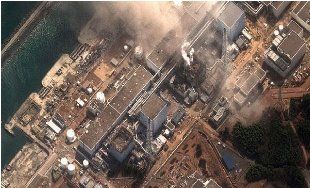
Slika 20. Oštećenje kompleksa nuklearne elektrane Fukushima Daiichi [38]
