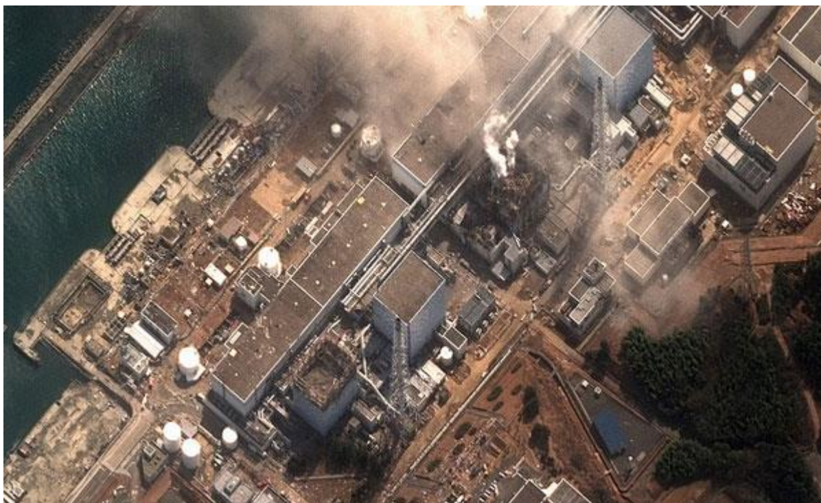
Slika 20. Oštećenje kompleksa nuklearne elektrane Fukushima Daiichi [38]
