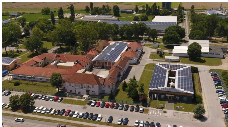
Slika 14. Solarna elektrana Genera [19]
