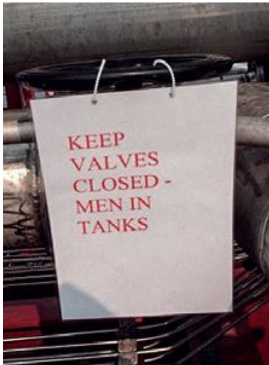
Slika 3. Znak upozorenja prikazan na ventilu
