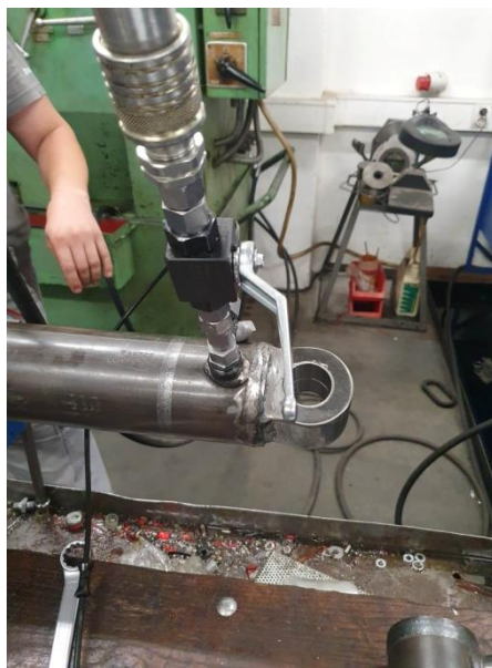
Slika 92. Zatvoren ventil priključnice (1).
