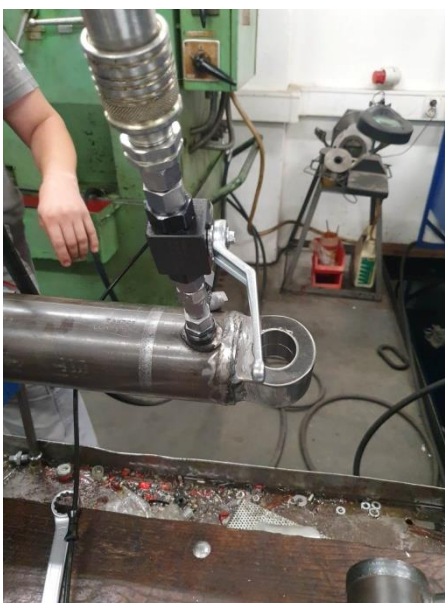
Slika 92. Zatvoren ventil priključnice (1).
