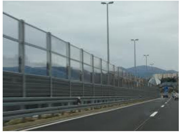
Slika 6 i slika 7. Primjeri zaštite od buke – bukobrani na prometnicama
