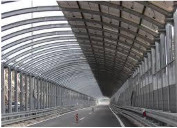
Slika 6 i slika 7. Primjeri zaštite od buke – bukobrani na prometnicama
