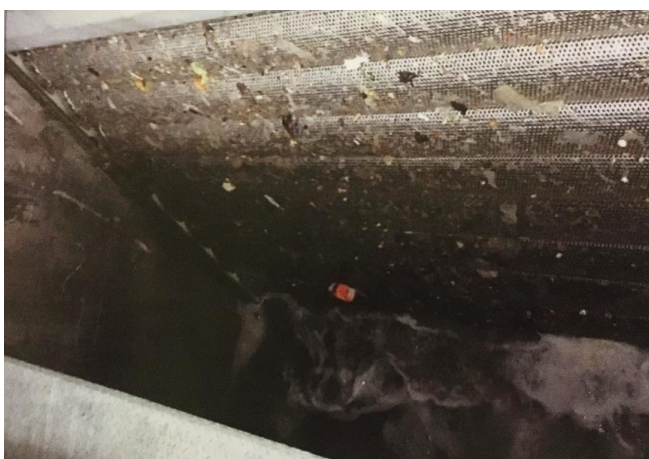
Slika 6. Rešetka uređaja za pročišćavanje u Zagrebu (Tušar, 2009.)
