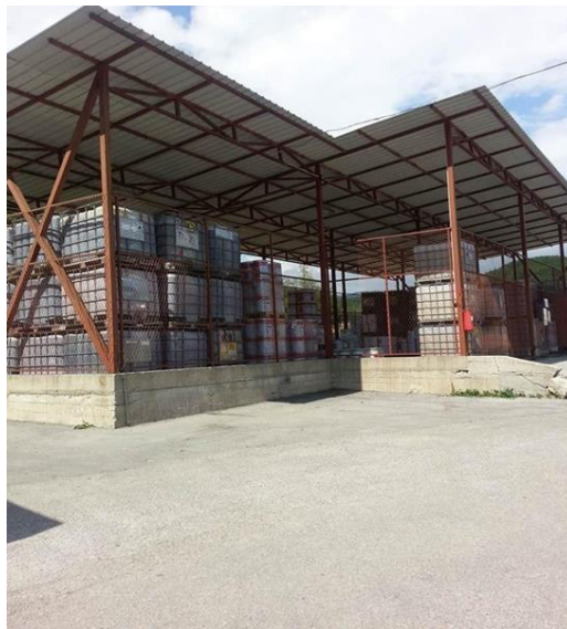
Slika 21: Skladište zapaljivih tekućina na otvorenom prostoru
