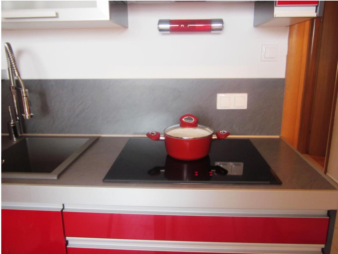
Sl. 12. Bonpet ampula postavljena iznad štednjaka [11]
