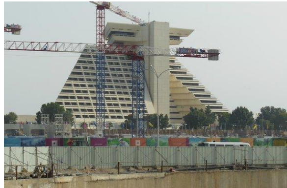
Slika 4. Gradnja Sheraton Doha Hotela
