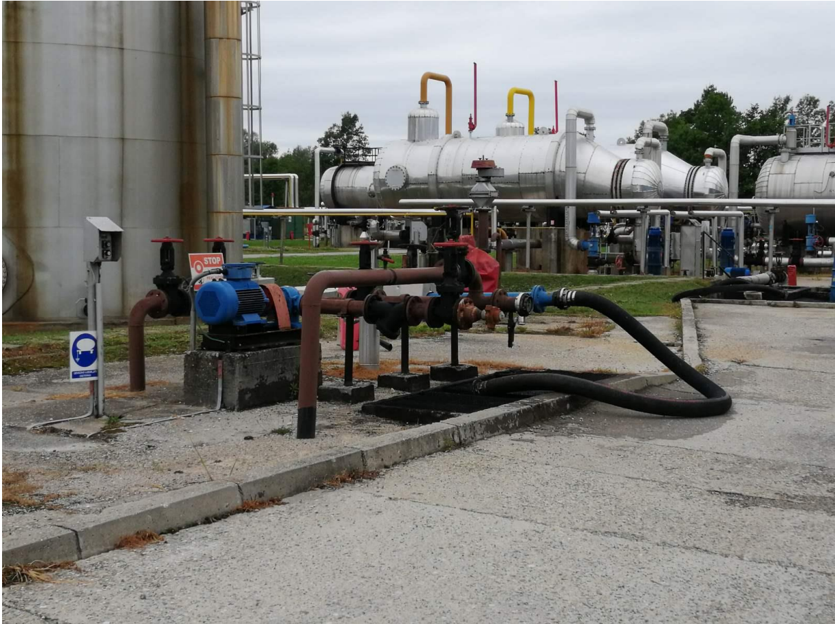
Slika 6. punilište auto-cisterni [19]
