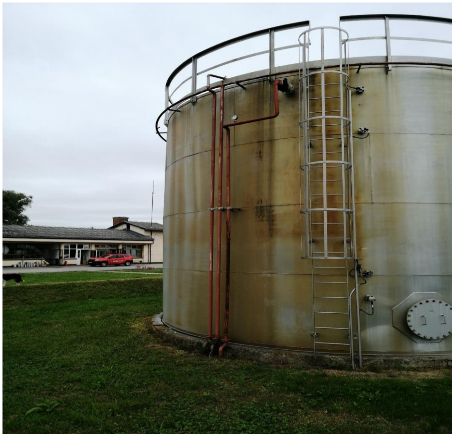
Slika 11. Stabilno hlađenje vodom [19]
