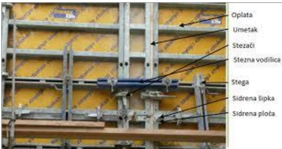
Slika 5. Dijelovi za spajanje oplata
