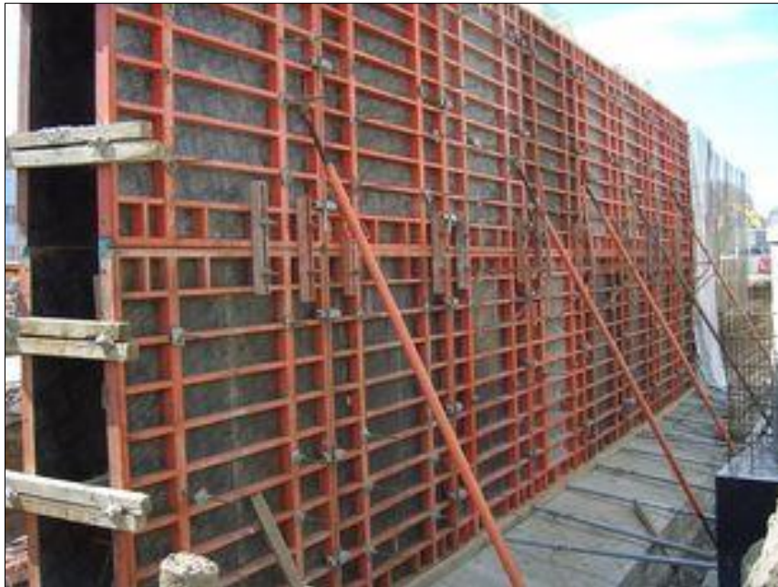
Slika 4. Velikoplošna oplata za vertikalne konstrukcije
