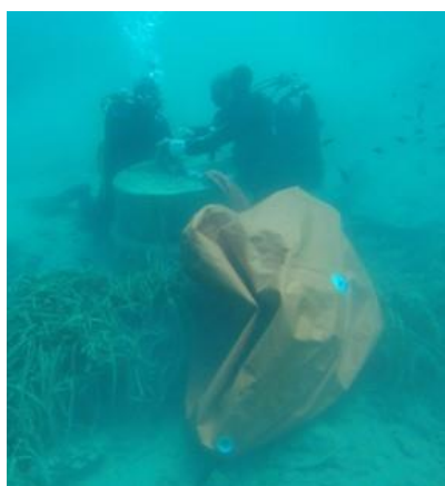
Sl. 35. Postavljanje i napuhavanje padobrana [3]
