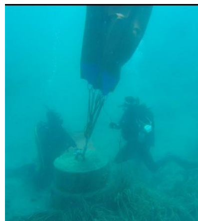
Sl. 35. Postavljanje i napuhavanje padobrana [3]
