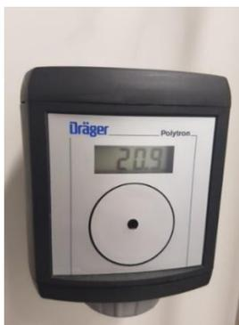
Slika 16. Mjerač koncentracije kisika u prostoru dio je sustava alarmiranja niske koncentracije
