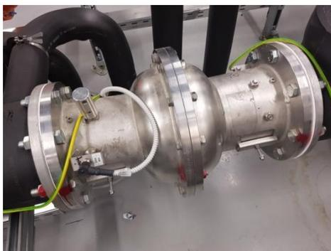
Slika 25. Ventil koji se u slučaju eksplozije zatvara i sprečava širenje eksplozije u ostale dijelove postrojenja. Ventil je napravljen od nehrđajućeg čelika, jer kroz njega prolazi čisti zrak koji dolazi u kontakt s proizvodom. Izlazni ventil je od običnog čelika.
