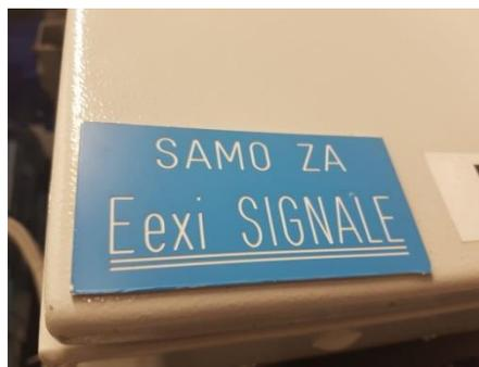
Slika 23. Oznaka na elektroormaru u kojem se nalaze pex uređaji
