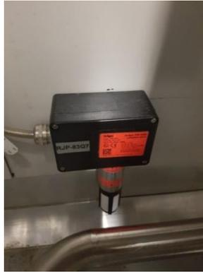
Slika 17. Detektor ispuštanja štetnih ili eksplozivnih para dio je sustava alarmiranja
