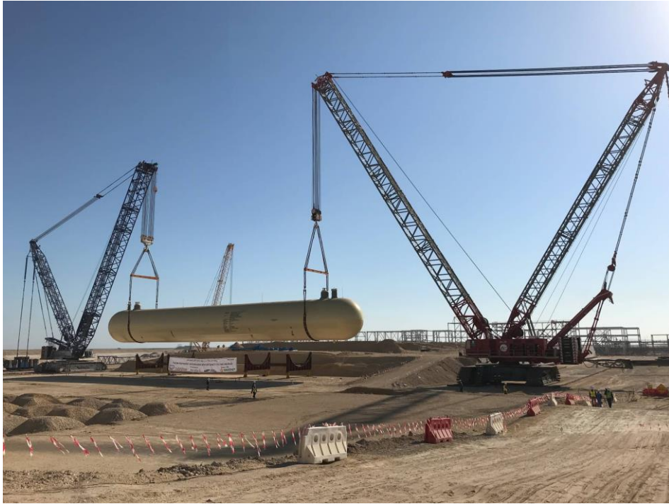
Slika 7. Pozicioniranje spremnika na temelje Izvor: https://www.petrofac.com/petrofacts/bullets/
