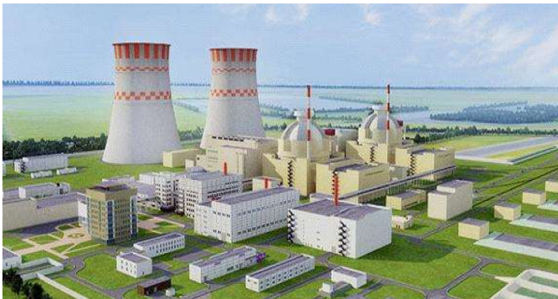
Slika 1. Budući izgled nuklearne centrale Rooppur [1]
