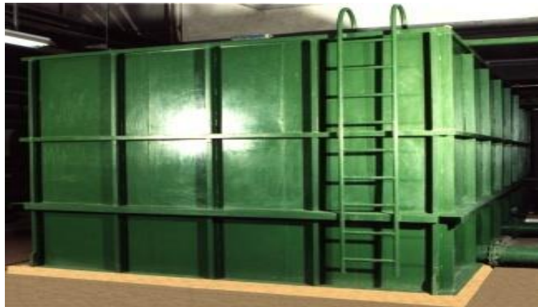
Sl. 12. Preljevni akumulacijski spremnik [16]
