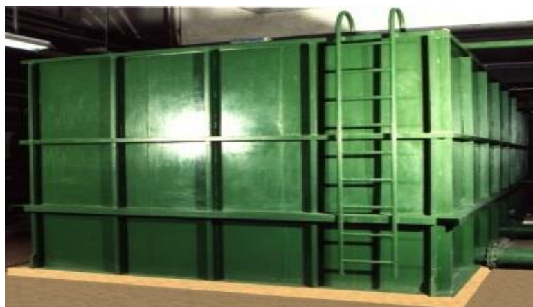
Sl. 12. Preljevni akumulacijski spremnik [16]
