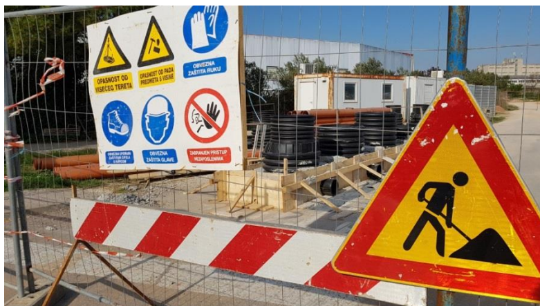
Slika 10. Oznake na ulazu u gradilište
