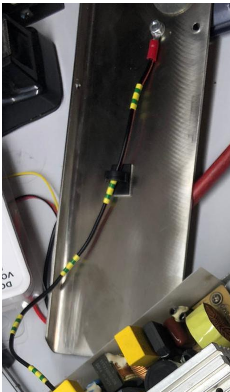
Slika 28. Provedba uzemljenja kućišta
