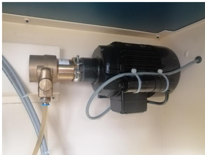
Slika 9 Jedinica za stvaranje podtlaka
