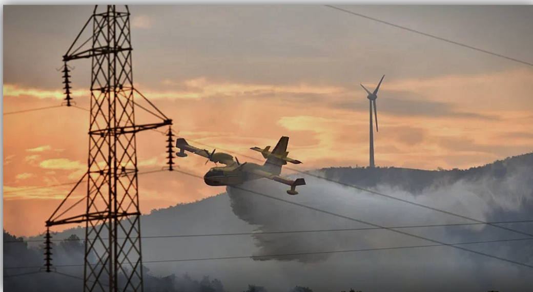
Slika 34. Dalekovod kao potencijalna opasnost [15]
