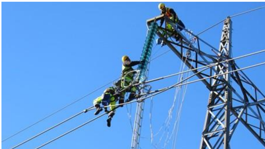
Slika 1.Radnici rade na postavljanju dalekovoda
