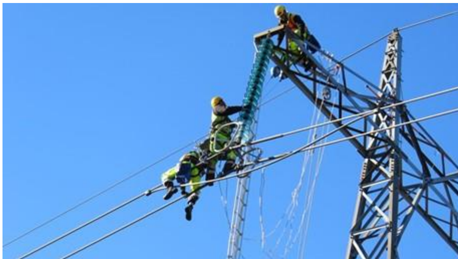
Slika 1.Radnici rade na postavljanju dalekovoda
