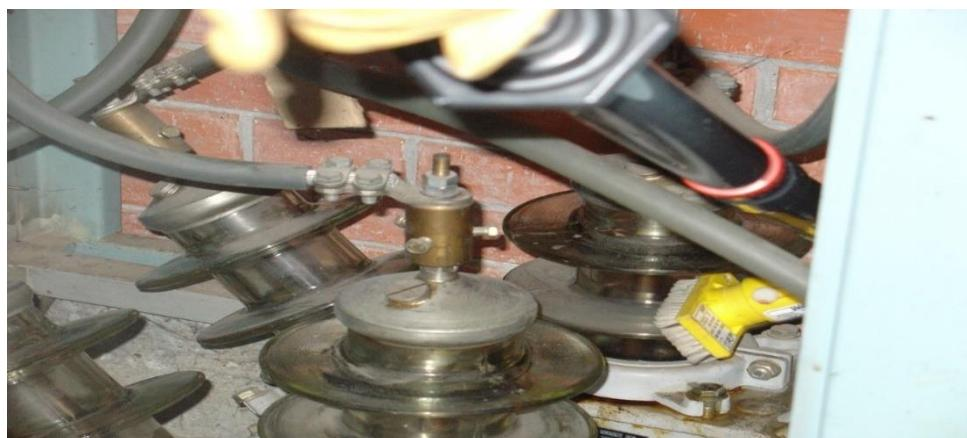
**Slika 3.** Čišćenje izolatora četkom
