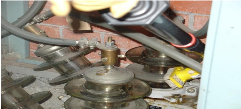
Slika 3. Čišćenje izolatora četkom
