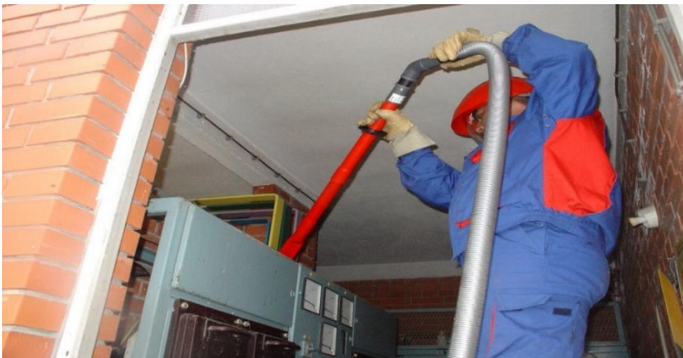
Slika 4. Čišćenje unutrašnjosti TS usisavačem
