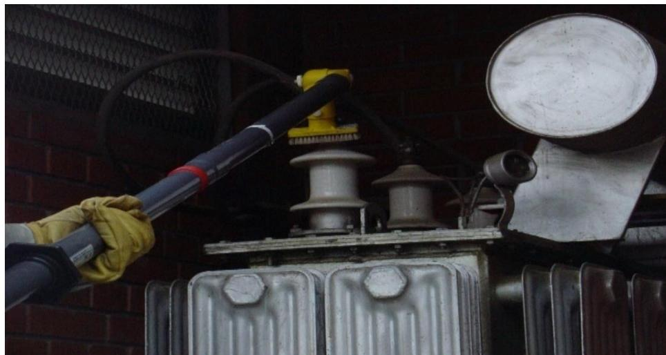
**Slika 5.** Čišćenje dijelova na transformatoru sa zaobljenom četkom
