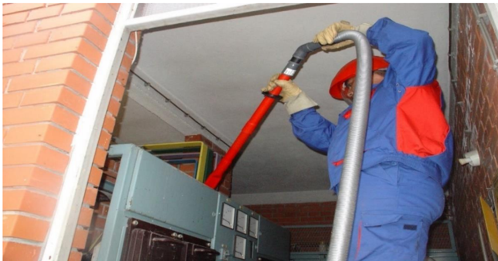
Slika 4. Čišćenje unutrašnjosti TS usisavačem
