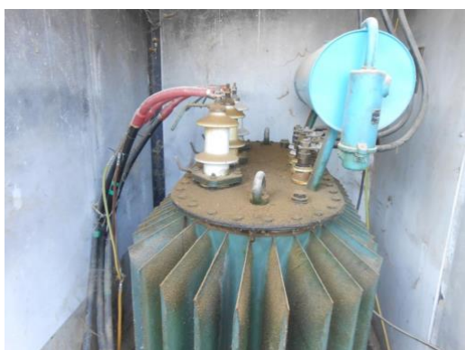
Slika 17. Čišćenje TS metodom, Kutina (prije)
