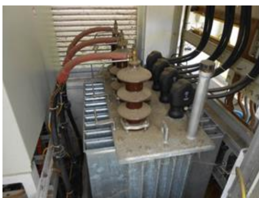
Slika 13. Čišćenje TS metodom (prije)
