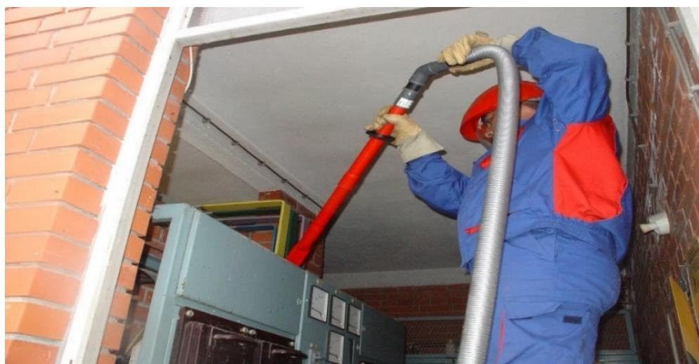
**Slika 4.** Čišćenje unutrašnjosti TS usisavačem
