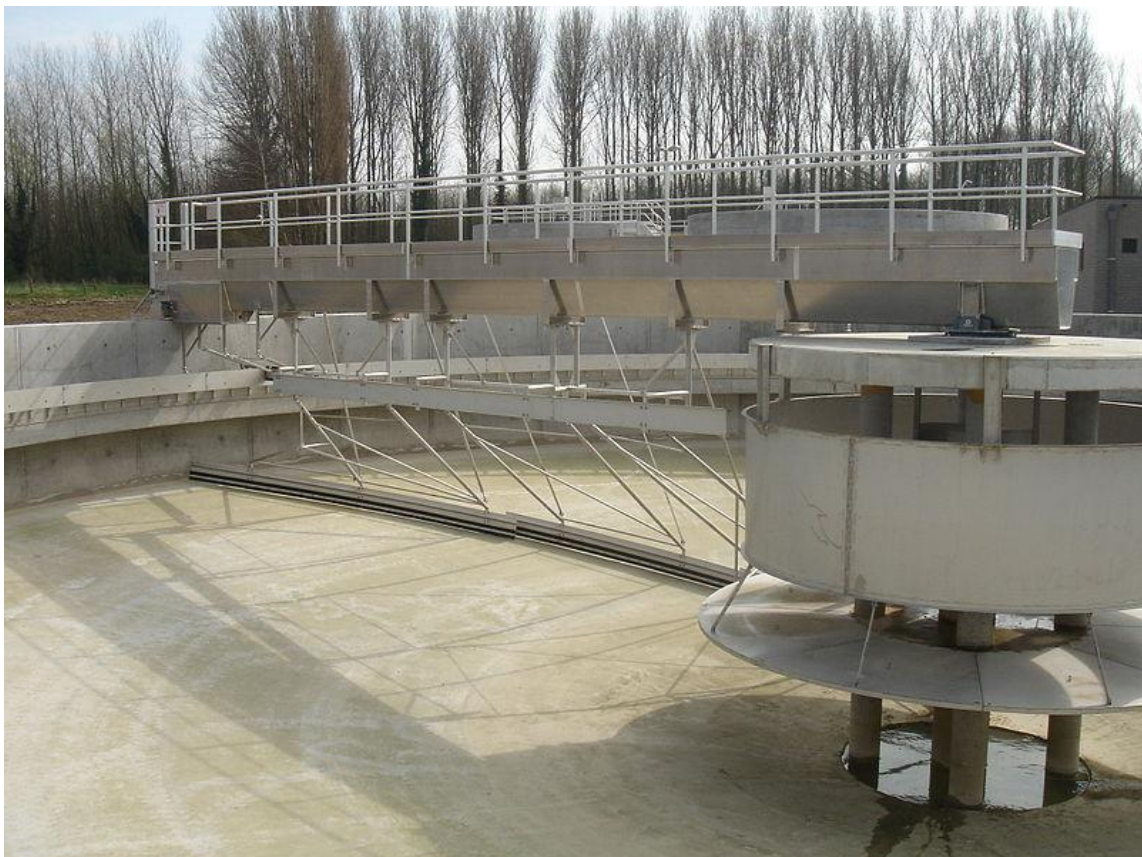
Slika 2. Naknadni taložnici najčešće imaju kružni tlocrt.
