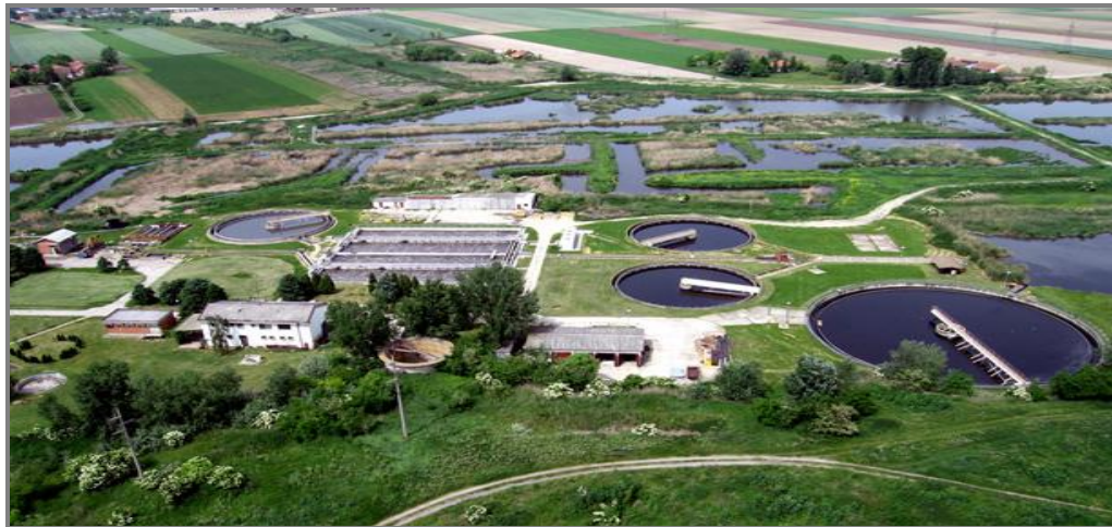
Slika 5. Pročišćivači otpadnih voda
