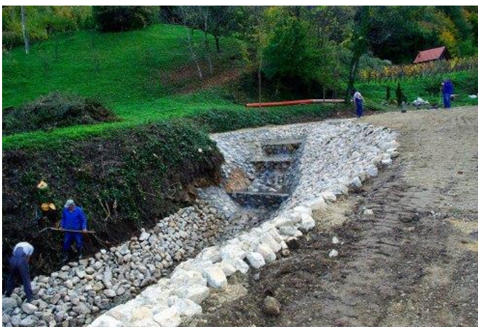
Slika 17) Izgradnja korita vodotoka
