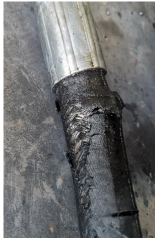
Slika 64. Oštećenja hidrauličnog fleksibilnog voda
