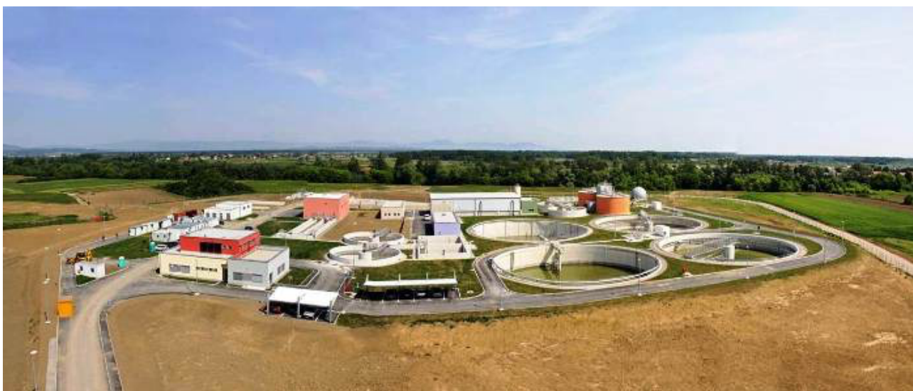
Slika 5. Uređaj za pročišćavanje otpadnih voda grada Karlovca i Duge Rese – UPOV
