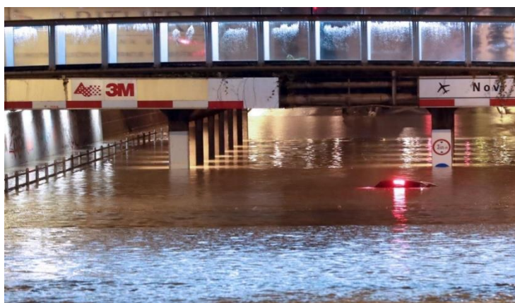
Slika 4. Poplavljen podvožnjak u Zagrebu, onemogućuje prolaz vatrogascima [11]
