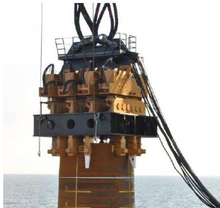
Slika 23. Četiri vibratora sastavljeni kod izgradnje podmorske vjetroelektrane [23]
