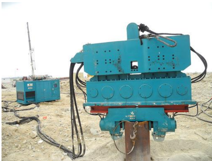
Slika 18. Primjena vibracijskog zabijača u praksi [27]
