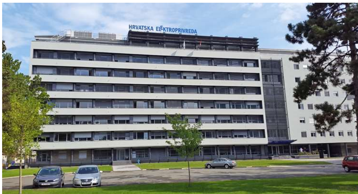
Slika 1. Kompleks zgrada Hrvatska elektroprivreda [1]
