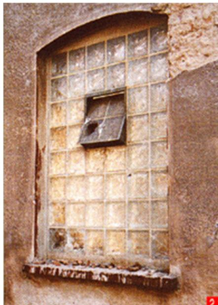
Slika 26. - Prozor ostakljen staklenim opekama nakon požara[32]
