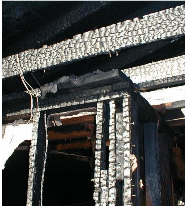
Slika 16. - Karbonizirane naprsline u obliku tzv. „krokodilske kože“ (eng. Alligatoring)[31]
