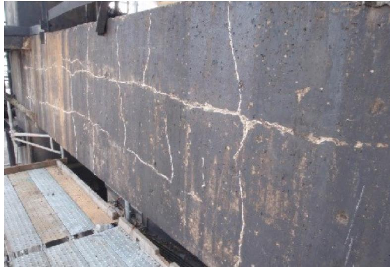
Slika 18. - Pucanje betona uslijed djelovanja požara (dehidracija betona)[33]
