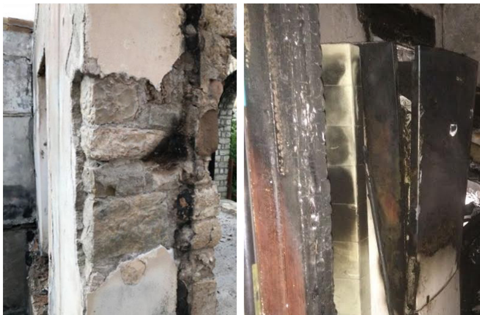
Slika 25. - Usporedni prikaz zaobljavanja uglova pravokutnih rubova kamena i drveta[42,43]
