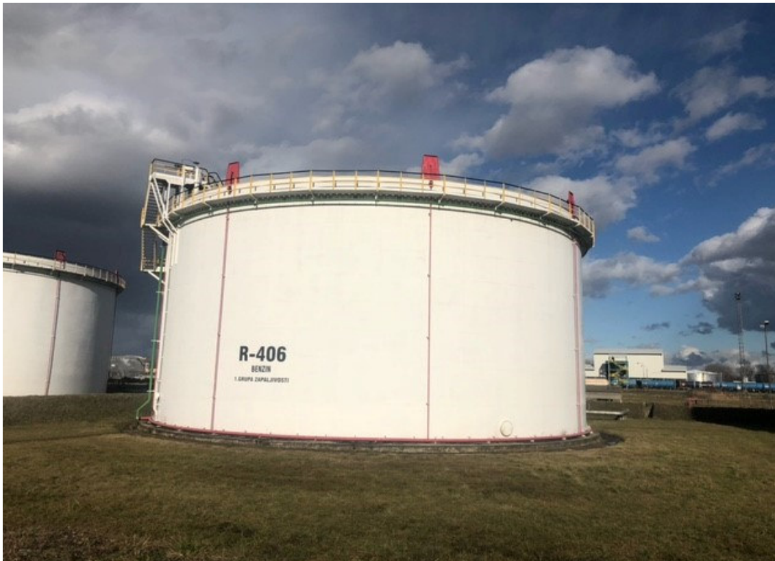
Slika 7. Sustav cjevovoda gašenja i hlađenja spremnika [7]
