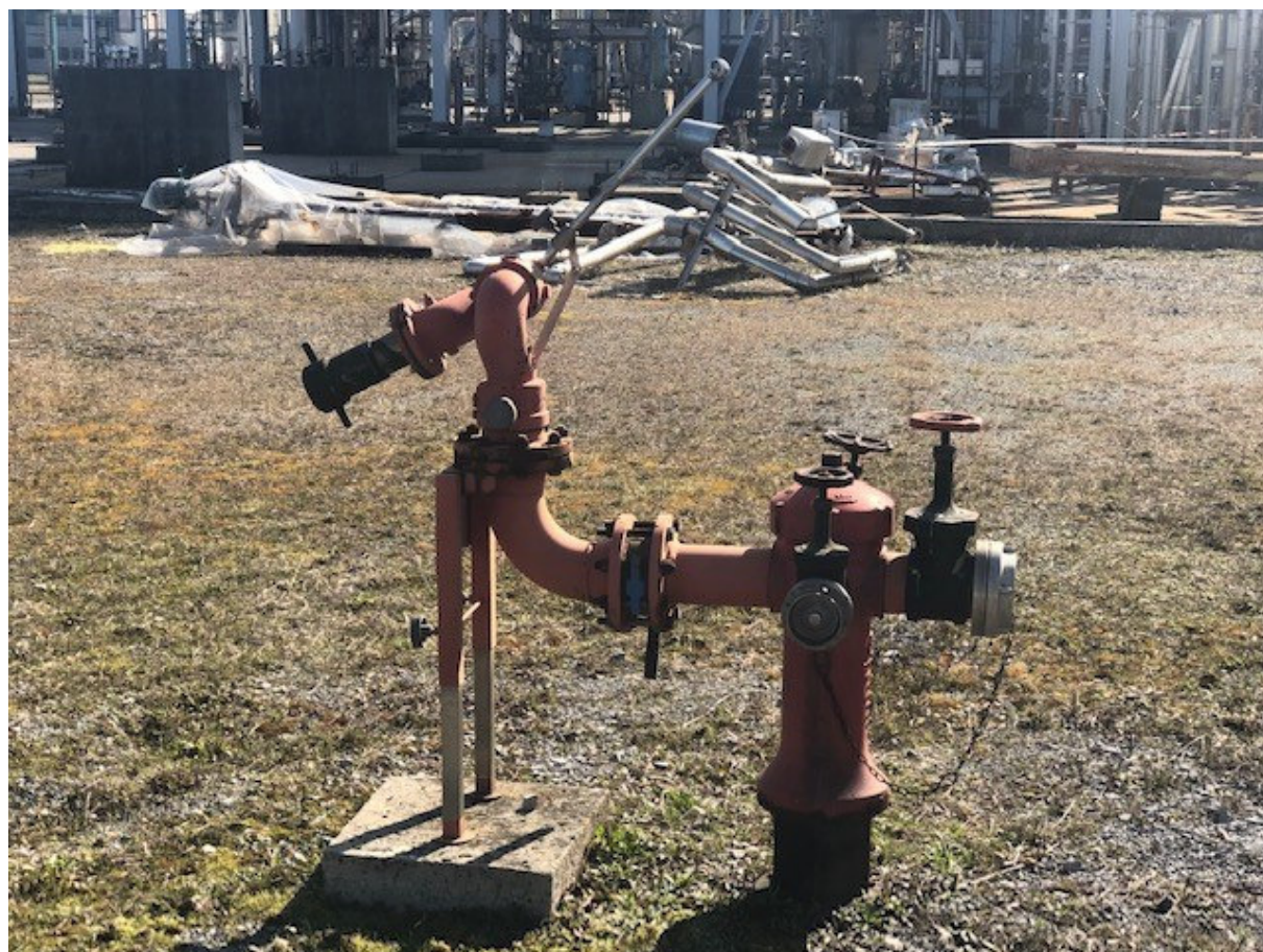
Slika 12. Stabilni bacač vode na SRU [7]
