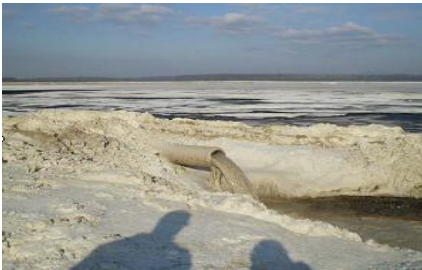
Slika 10: Prikaz ispuštanja fosfogipsa na odlagalište
