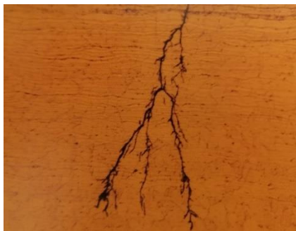
Slika 4. Primjeri drugih korozijskih oštećenja [1]
