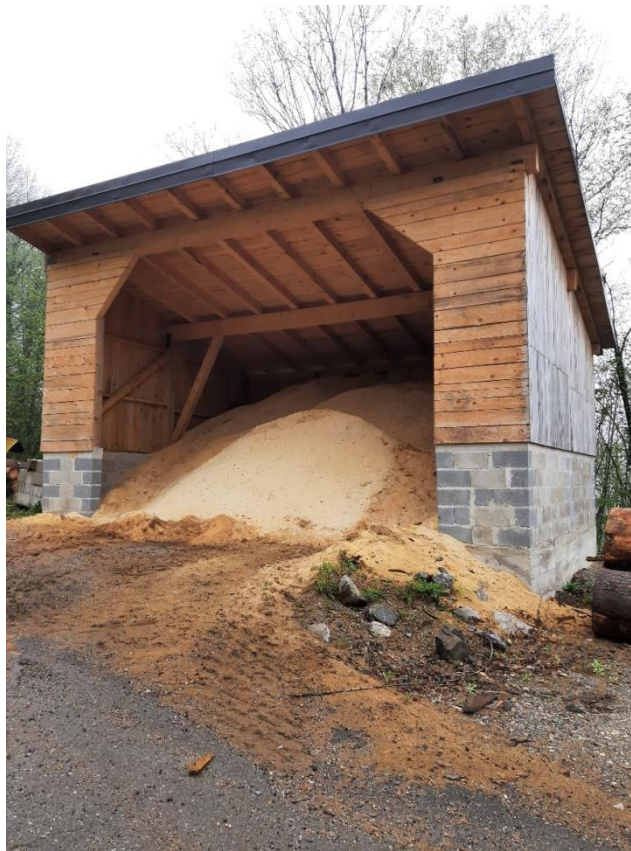
Slika 20: Prostor za skladištenje piljevine
