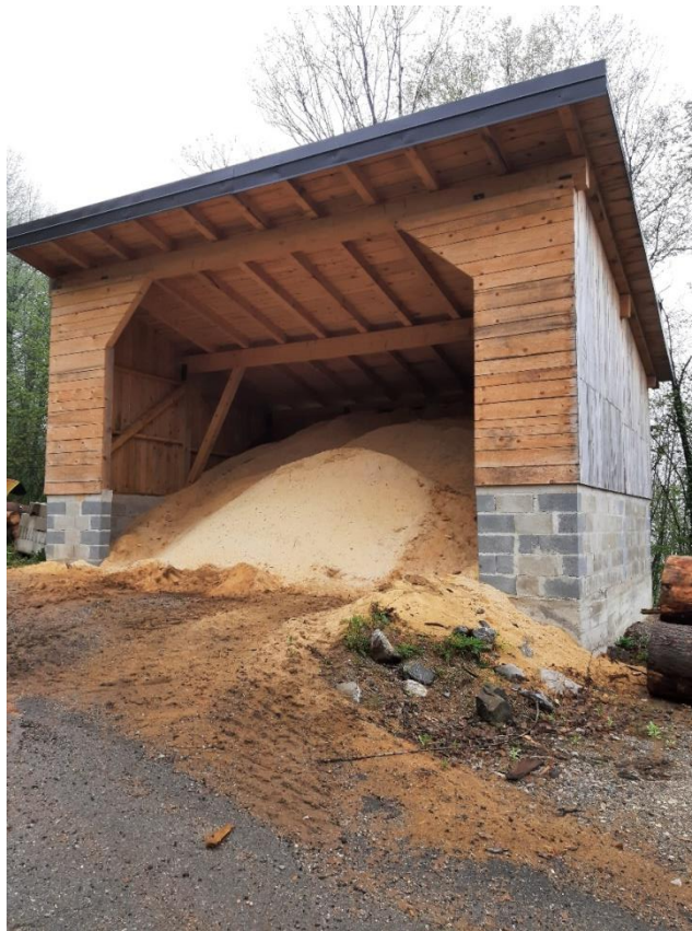
Slika 20: Prostor za skladištenje piljevine
