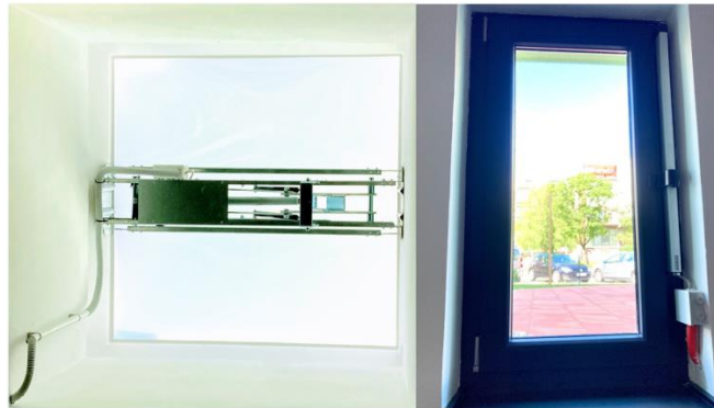
Slika 9. Automatski sustav odimljavanja (otvori za odimljavanje) [1]
