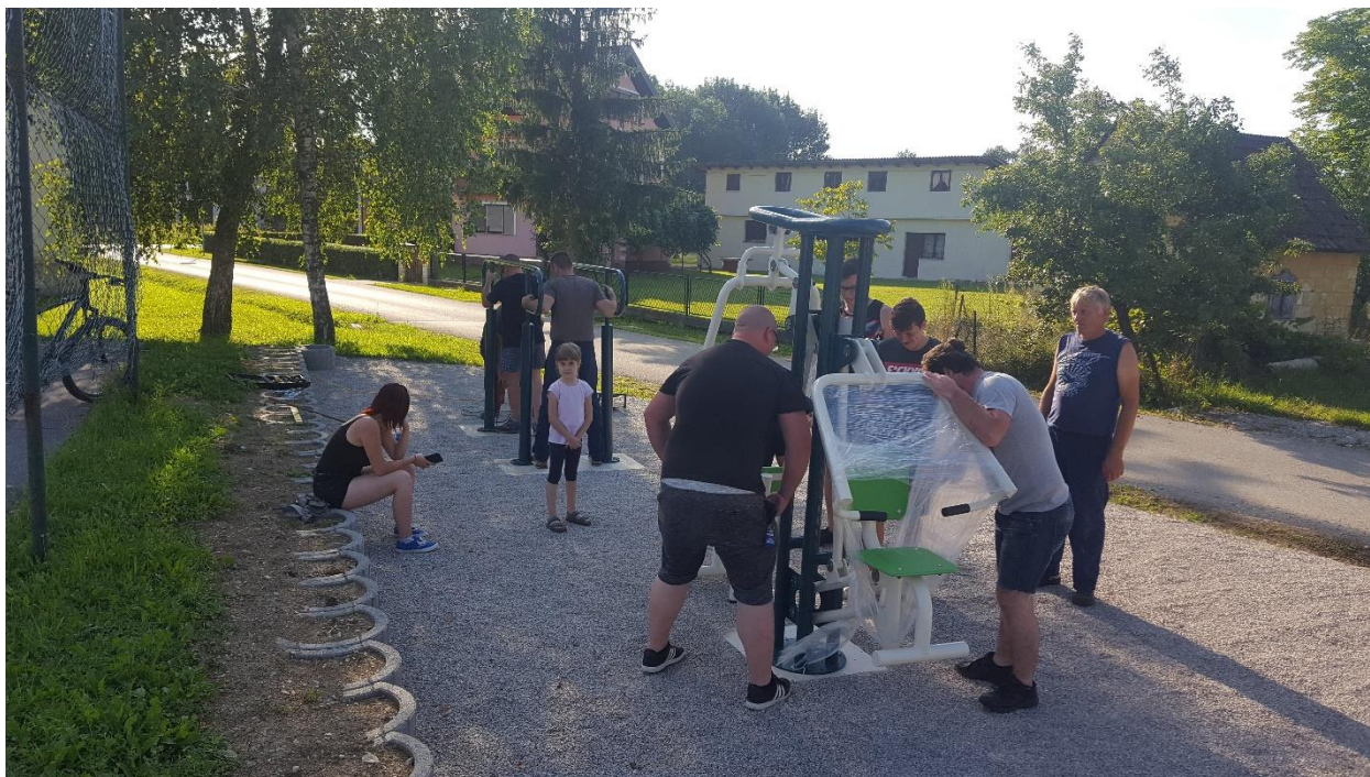
Slika 7. Volonteri postavljaju fitness sprave u sklopu projekta „Fitness pod vedrim nebom“
