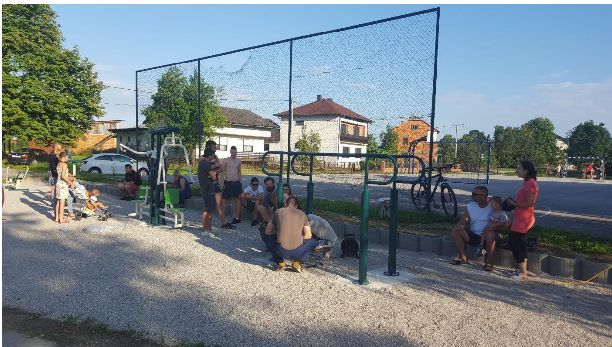
Slika 12. Volonteri postavljaju fitness sprave u sklopu projekta „Fitness pod vedrim nebom“
