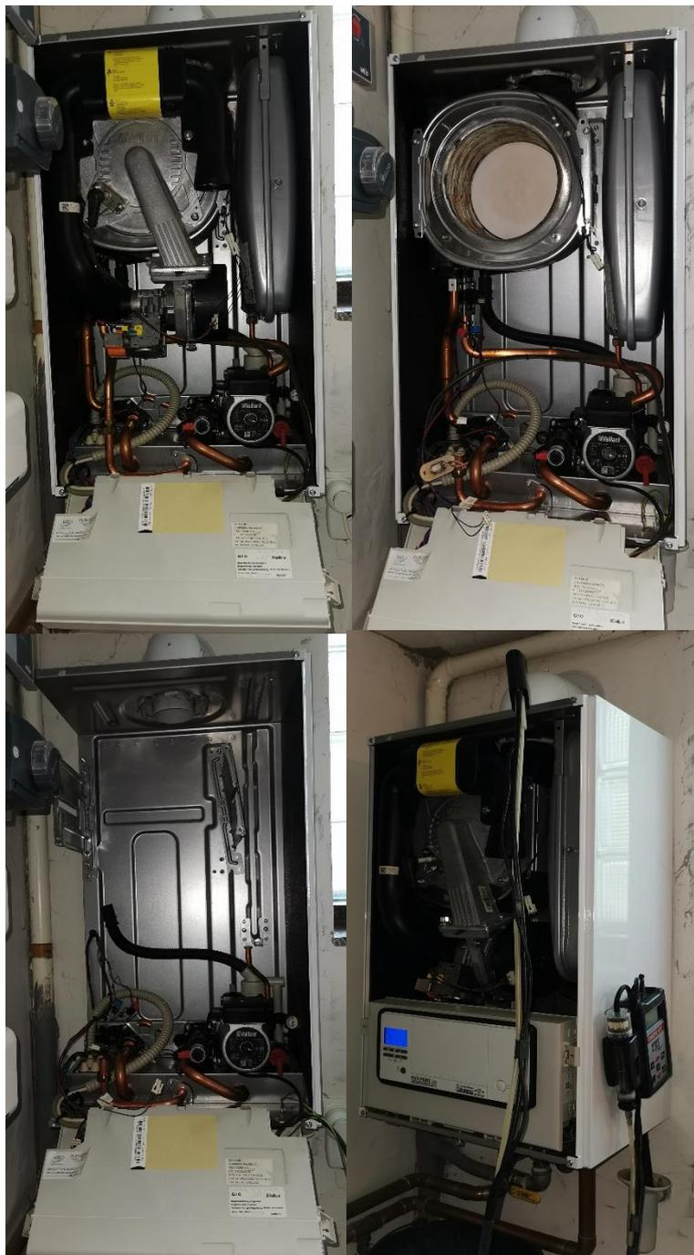
Slika 17: Predodžba servisa po fazama: prvi vizualni pregled, otvaranje, rastavljanje, provjera mjerenjem
