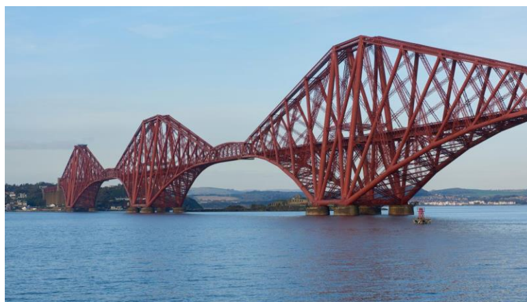
Slika 1. Čelični most Forth Bridge [3]
