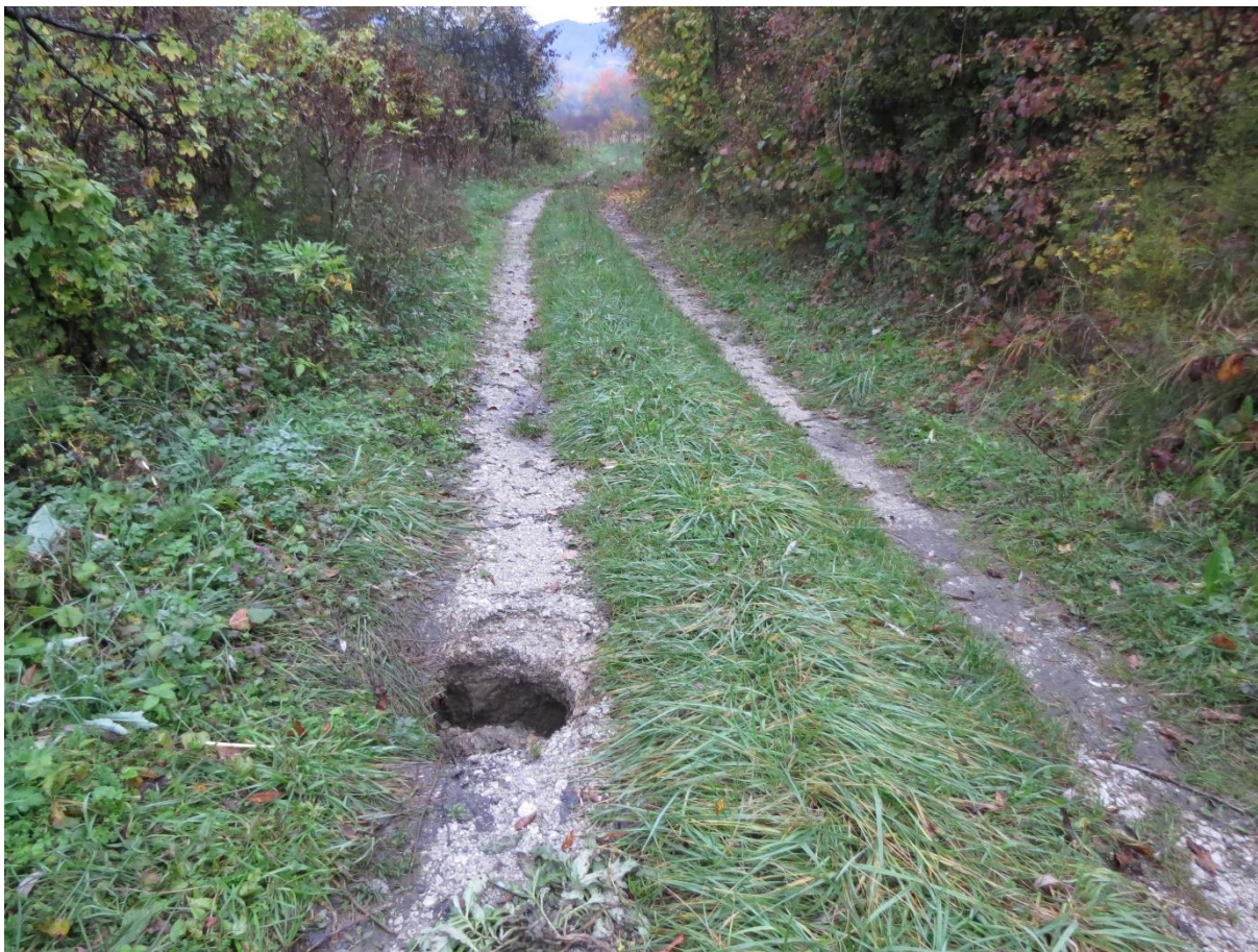
Slika 15 Rupa na kolotečini nastala dabrovim potkopavanjem ispod poljskog puta (Izvor: T. Dumić)
