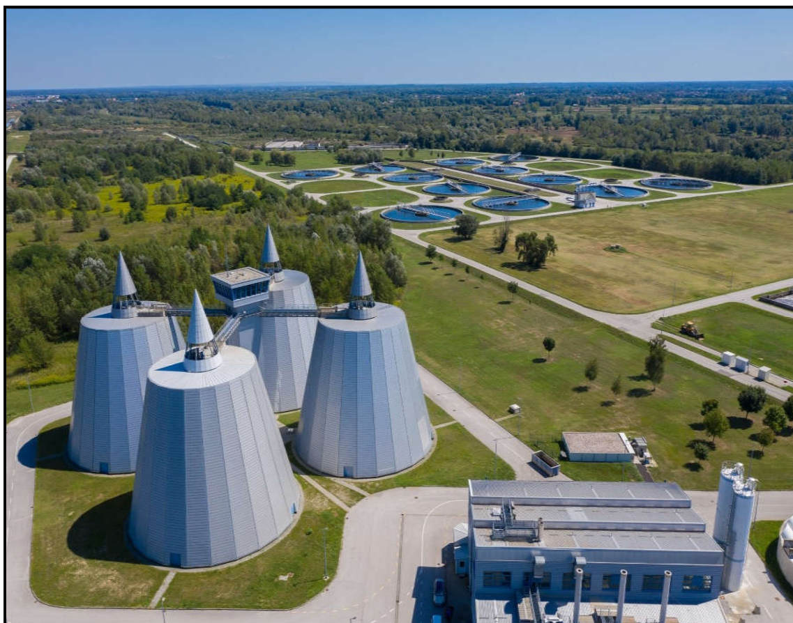
Slika 2. Prikaz centralnog uređaja za pročišćavanje otpadnih voda (CUOPVZ) [13]
