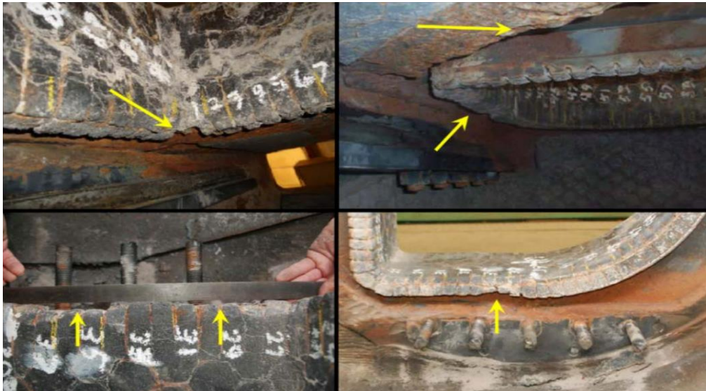
Slika 2. Korozija na ventilu kao uzrok nesreće [9]
