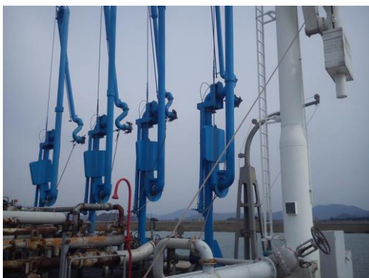
Slika 7. Pretakalište brodova i zglobni utakači.
