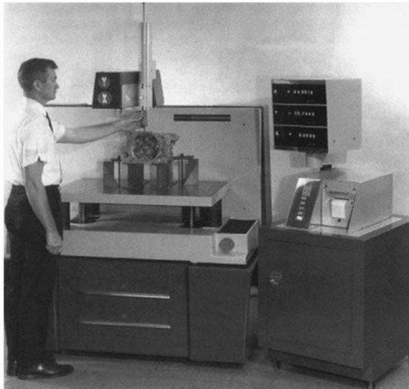
Slika 2 Prikaz ručnog pomicanja probe
