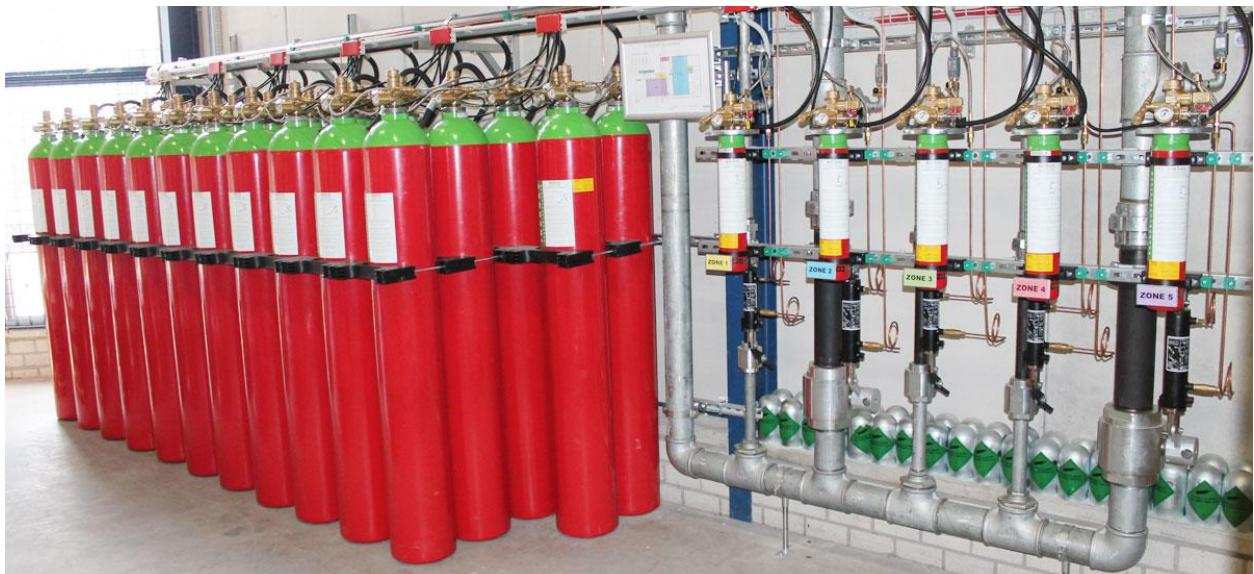
Slika 17. INERGEN protupožarni sustav [16]
