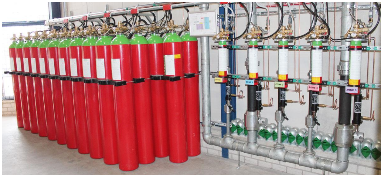
Slika 17. INERGEN protupožarni sustav [16]
