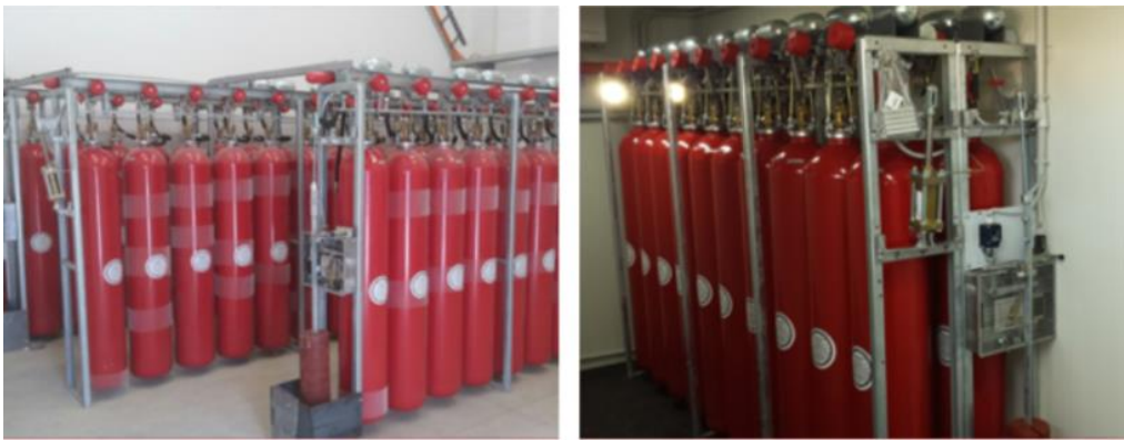
Slika 12. Visokotlačni sustav za gašenje požara ugljičnim dioksidom [7]
