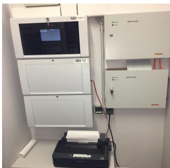
Slika 4. Vatrodojavna centrala s pisačem [5]
