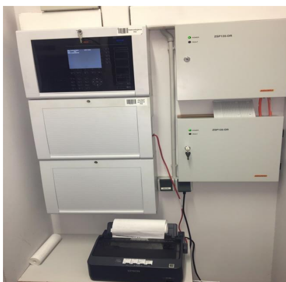
Slika 4. Vatrodojavna centrala s pisačem [5]
