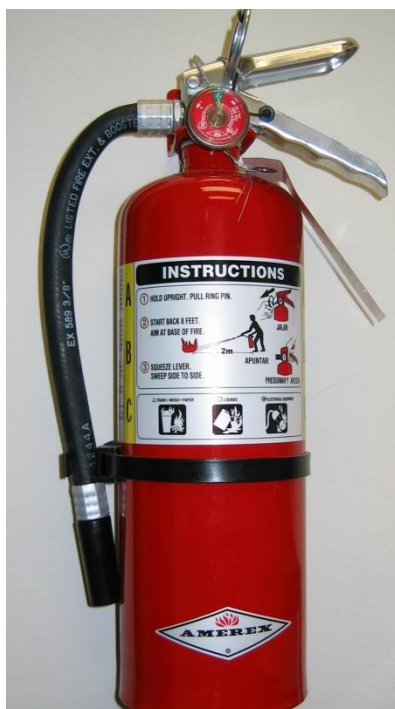
Slika 5. Vatrogasni aparat punjen prahom [7]
