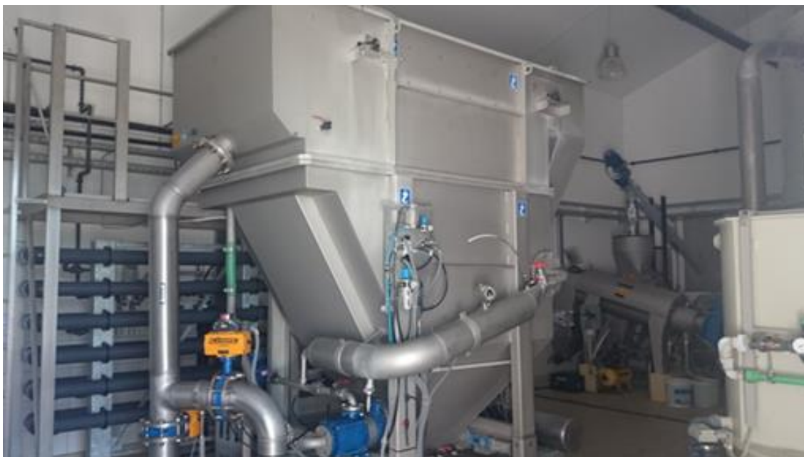
Slika 9: Tehnološka linija DAF [18]
