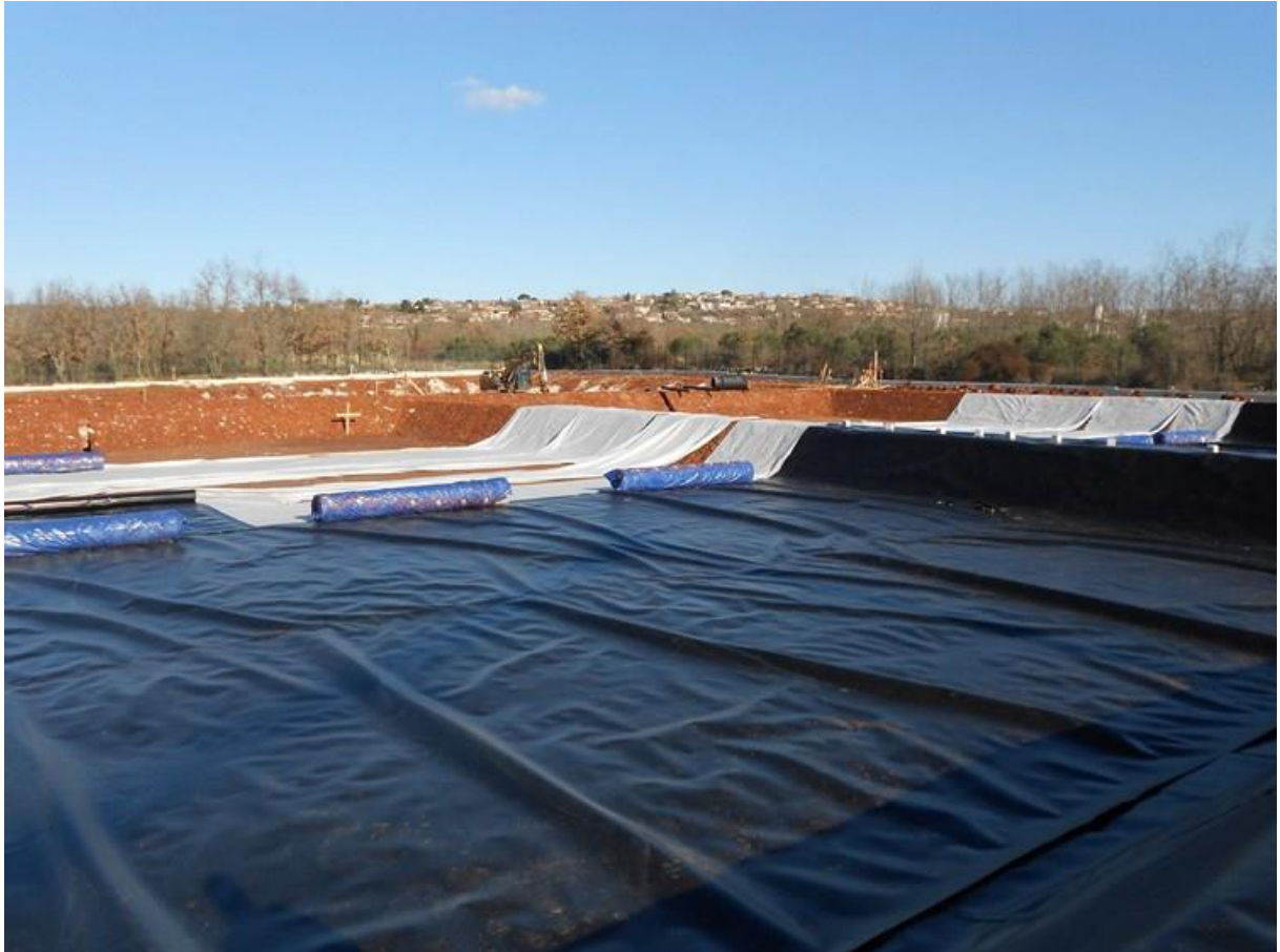
Slika 2 - Postavljena nepropusna podloga (Parentium.com, 2016)
