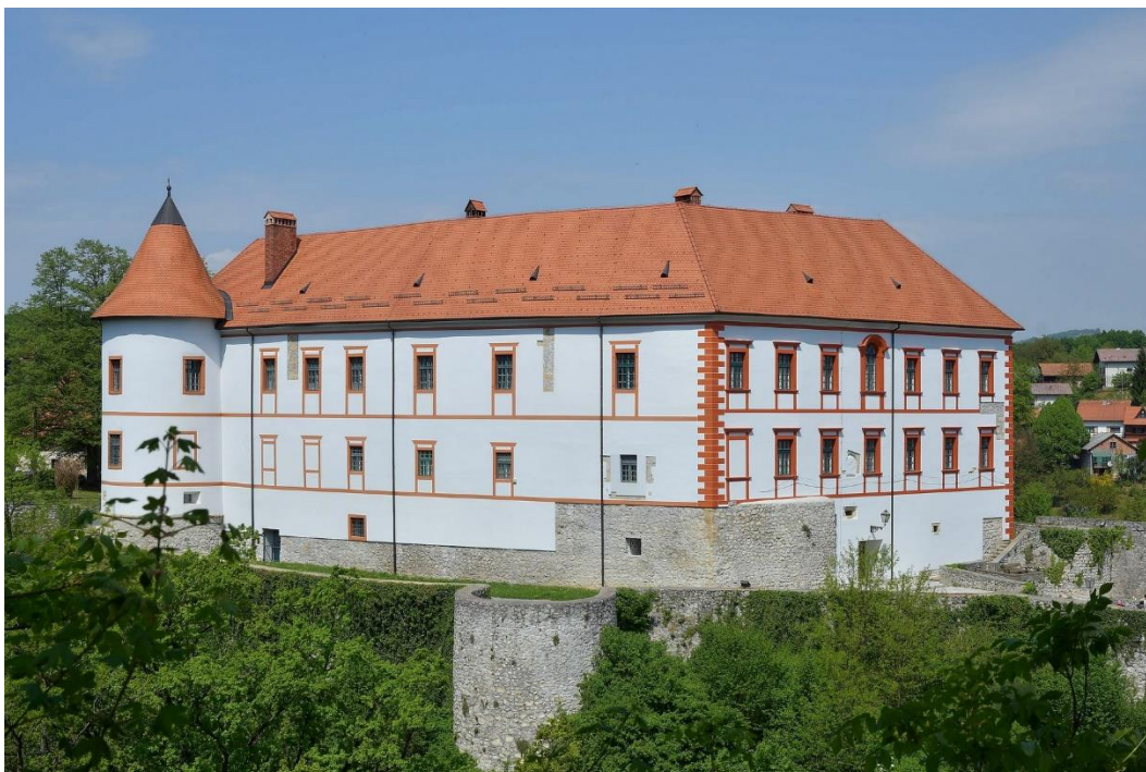
Slika 23: Obnovljeno istočno i južno krilo
