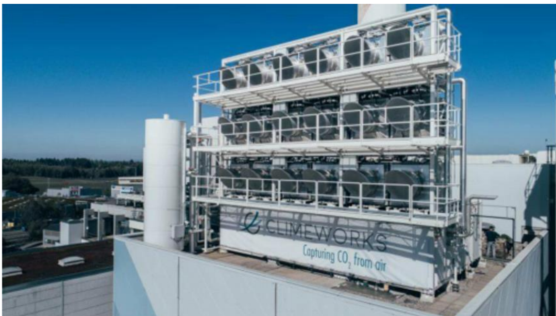
Slika 5. Prvo svjetsko komercijalno postrojenje za izravno sakupljanje CO 2 iz atmosfere koje je smješteno u Hinwilu u Švicarskoj [34]
